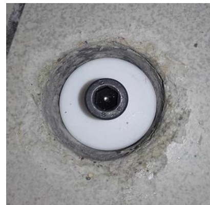
La tête de l'ouvrage avec son bouchon avant cimentation
